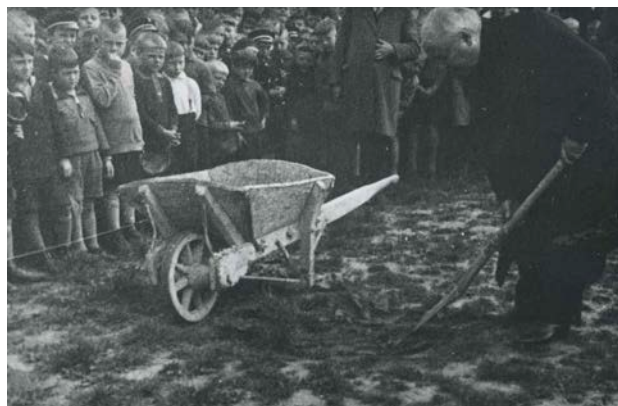
Der erste Spatenstich
